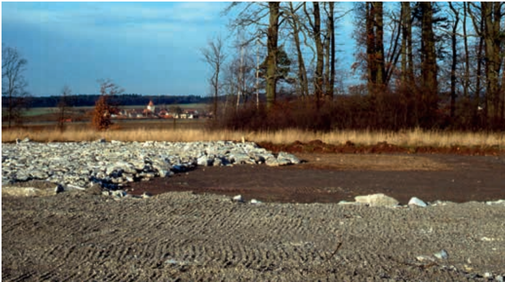
11 | Auftrag aus Groggips (Bildmitte links), Feingips (Vordergrund) sowie der abgeschobene, tonige Oberboden (Bildmitte rechts). Dort ist bereits ein Heuauftrag erkennbar.
